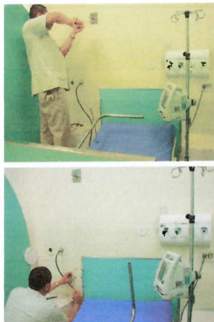
Figura 21 – Instalação do protótipo
